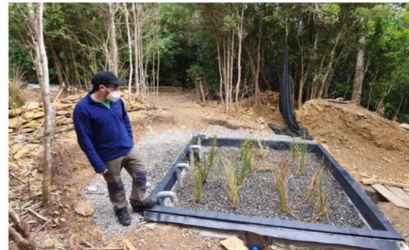
Uno de los humedales depuradores de agua artificiales ya construidos en la Región de los Ríos.
